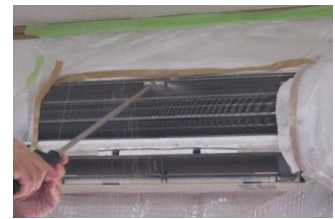
②室内器熱交換器薬品洗浄
